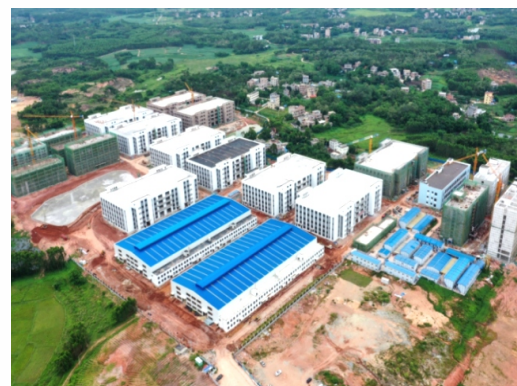
玉林铜精深加工产业基地项目
